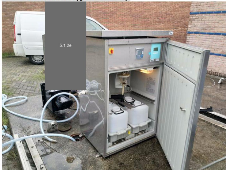
installeren monsternamekast gemaal Cambridgelaan
